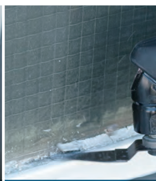
Rezanie tmelu a silikónu
